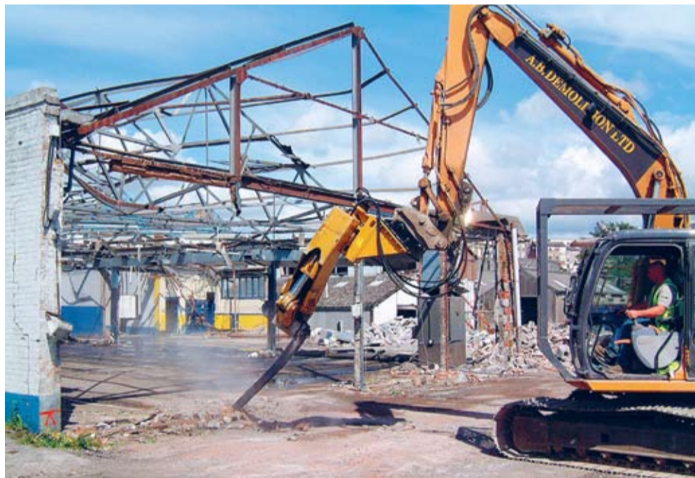
Sakse som denne, der kan monteres på en gravemaskine og tygge sig igennem selv meget tykt stål, er blandt nyhederne i Lesancos produktsortiment.
