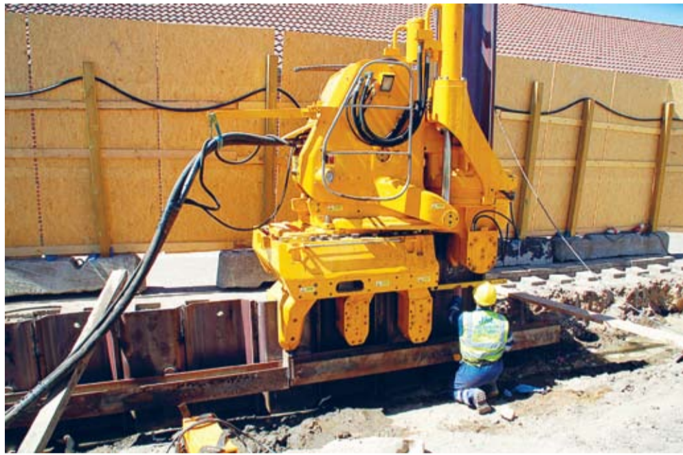
Lesanco ApS har blandt andet leveret denne hydrauliske pressemaskine til FN Fundering, der netop har løst en større funderingsopgave i Middelfart. Maskinen presser spunsene ned, uden at medarbejderne i de nærliggende virksomheder mærker eller hører noget som helst. Metoden er altså helt fri for vibrationer og dermed også meget skånsom mod de omkringliggende bygninger.
